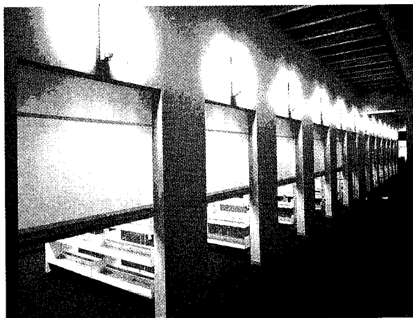
Hình 3-18. Ngăn cháy bằng cửa sập; Vách sợi silicat (Sợi thủy tinh đặc biệt được xử lý acid clohidric, làm khô, phủ một lớp chống nhiệt và nung để tạo thành sản phẩm)
