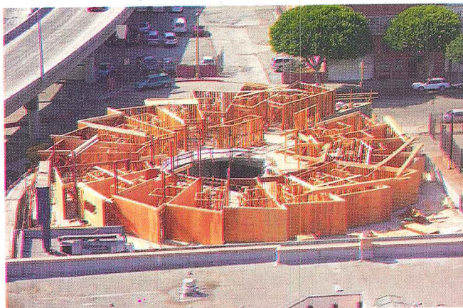
MỘT SỐ HÌNH ẢNH QUÁ TRÌNH THI CÔNG CÔNG TRÌNH
