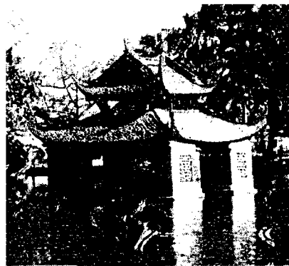
Hình 97 : Cụm kiến trúc chính của chùa là chùa Cả gồm 3 nhà lớn dựng trên nền cao bó đá hộc xanh. Lớp ngoài là tiền tế, lớp giữa thờ Phật, lớp trong thờ Từ Đạo Hạnh rộng nhưng thấp, kiểu thức cổ kính. Mái đồ sộ lợp ngói mũi hài to bản. Bộ khung 4 cột cái, 12 cột quân.
