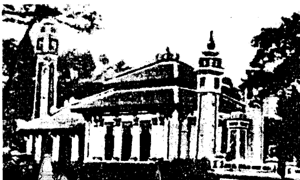
Hình 222: Nhà máy nước Vạn Niên
