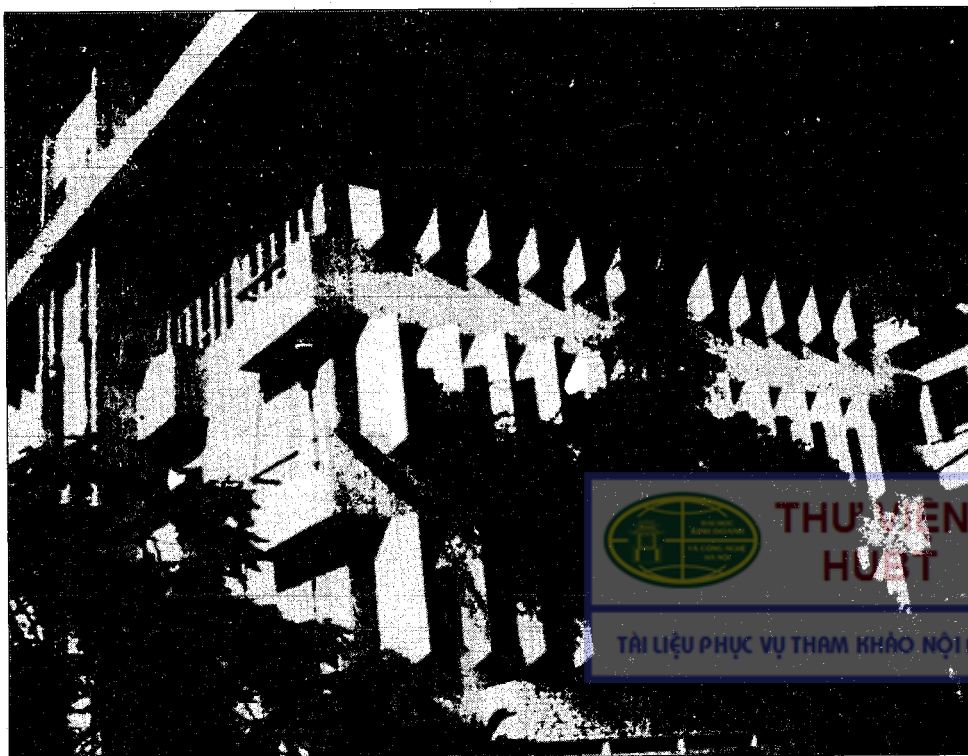
Hình 6.3. Tấm che nắng đứng, nghiêng với hướng cửa sổ 30^\circ .
