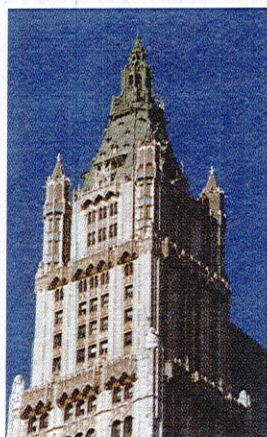
ẢNH CHỤP PHẦN ĐỈNH CÔNG TRÌNH
