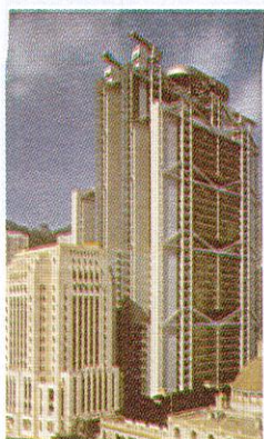
TRỤ SỞ NHÀ BĂNG HỒNG KÔNG VÀ THƯỢNG HẢI
