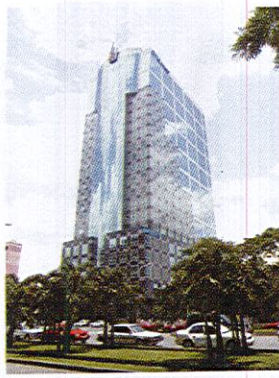
SUNWAR TOWER, THÀNH PHỐ HỒ CHÍ MINH
