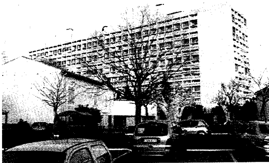
ẢNH CHỤP MẶT TRƯỚC CÔNG TRÌNH
