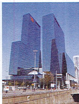
GEBOUW DELFTSE POORT, ROTTERDAM, HÀ LAN
