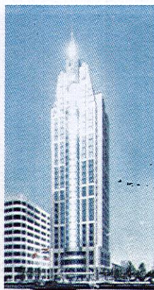
MILLENIUM TOWER, ROTTERDAM, HÀ LAN
