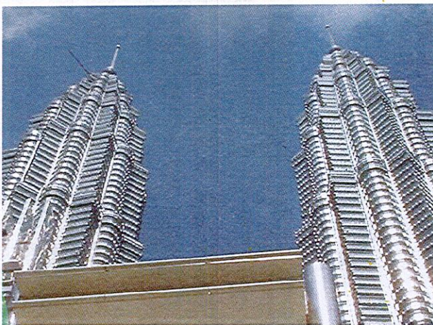
ẢNH CHỤP PHẦN ĐỈNH CÔNG TRÌNH
