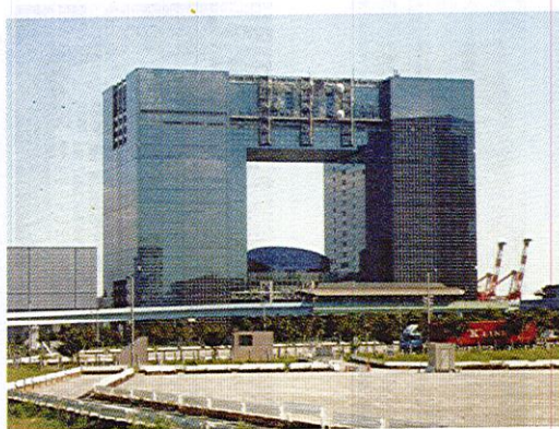
TOKYO TELECOM CENTER, TOKYO, NHẬT BẢN
