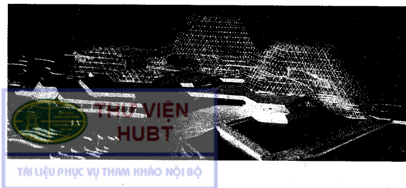
Hình 3.9. Kết cấu hệ lưới thanh không gian.
