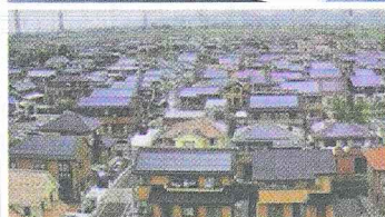
Hình B.105. Pin nhiệt năng nên được lắp hướng về phía Tây, nhiệt lượng mặt trời lớn hơn (ở bán cầu Bắc - đối với hệ thống không điều chỉnh được góc)
