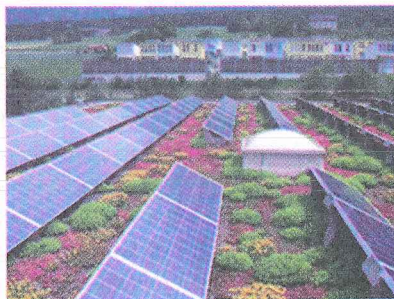
Hình B.42. Pin năng lượng mặt trời sử dụng tại sân xanh và đỉnh mái nhà
