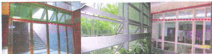
Hình B.140. Hệ thống cửa thông gió được mở về mùa hè [52]
