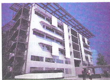
Hình B.1. Công trình UNDP (Green one) Nguồn: www.e4g.org
