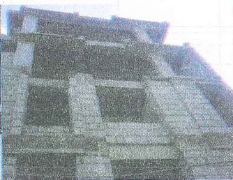
(b) Nhà sử dụng vật liệu AAC
