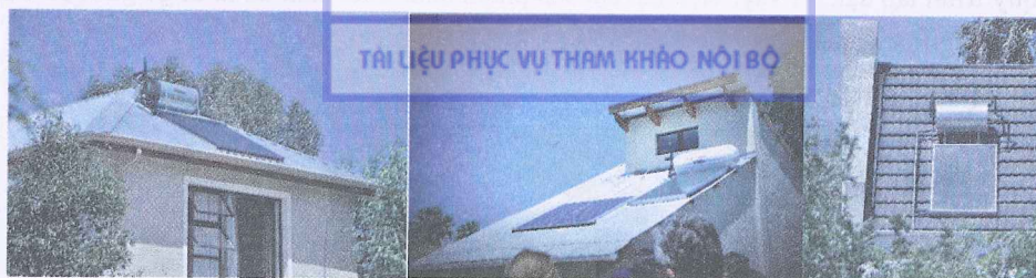
Hình B.89. Dùng pin mặt trời trong thực tế tại Nam Phi cho các công trình nhà ở riêng lẻ
